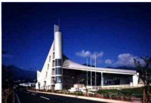
屋久島環境文化村センター （屋久島町宮之浦）
