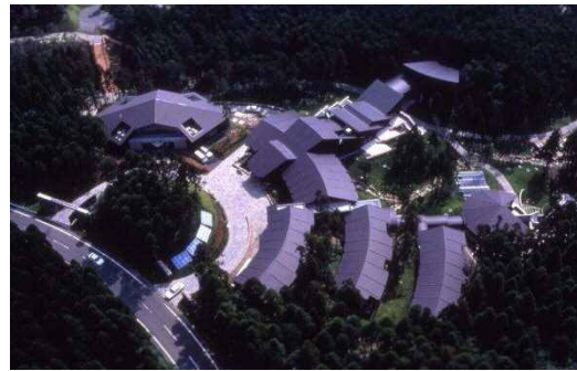
屋久島環境文化研修センター （屋久島町安房）
