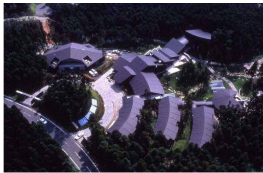
屋久島環境文化研修センター （屋久島町安房）
