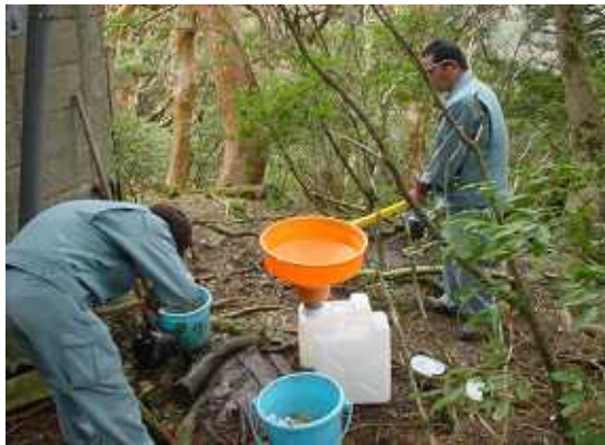
トイレからのし尿くみ出し
