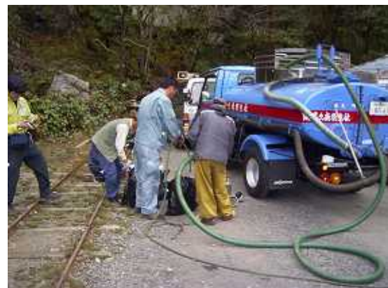
バキュームカーへ移し換え
