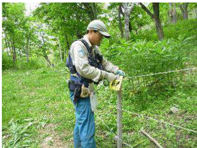
ヒグマの侵入を防ぐ電気柵の設置作業
